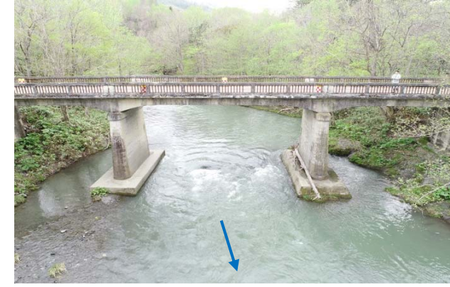
側面全景 下流側より
