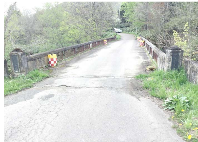
全景 A2側より
