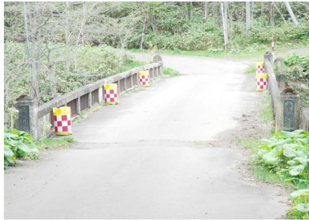
全景 A1側より
