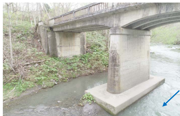
P2橋脚 A2橋台
