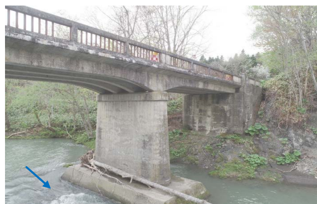
P1橋脚 A1橋台
