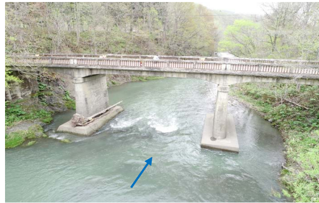
側面全景 上流側より
